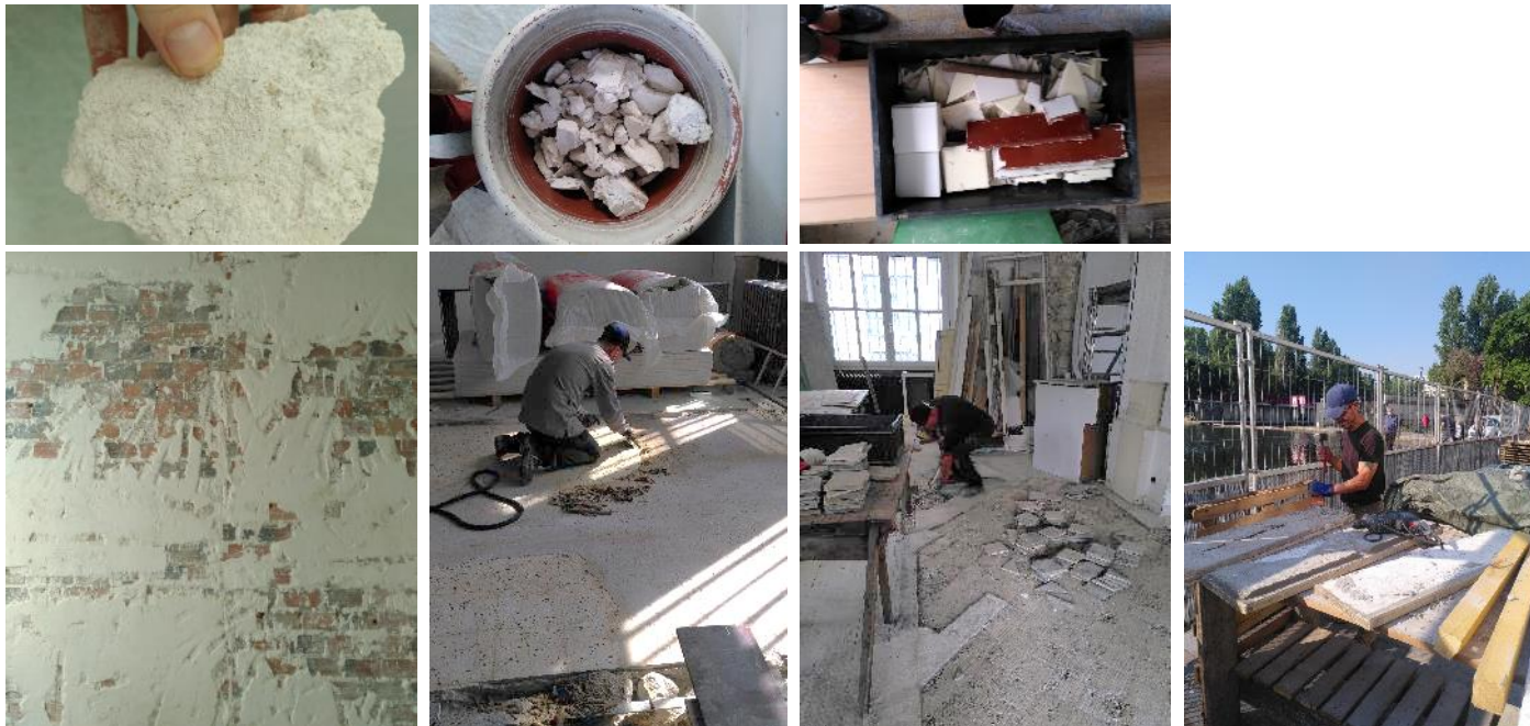
Chantier d'insertion au service du réemploi avec Travail et Vie. Déconstruction soignée - Préparation de la matière.
