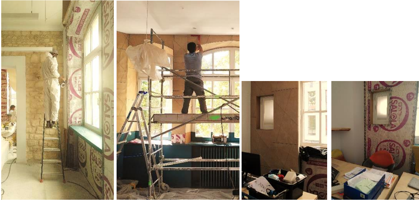
Isolation de l'étage avec Apij Bat Scop d'insertion et les Résilientes Emmaüs association d'insertion.
