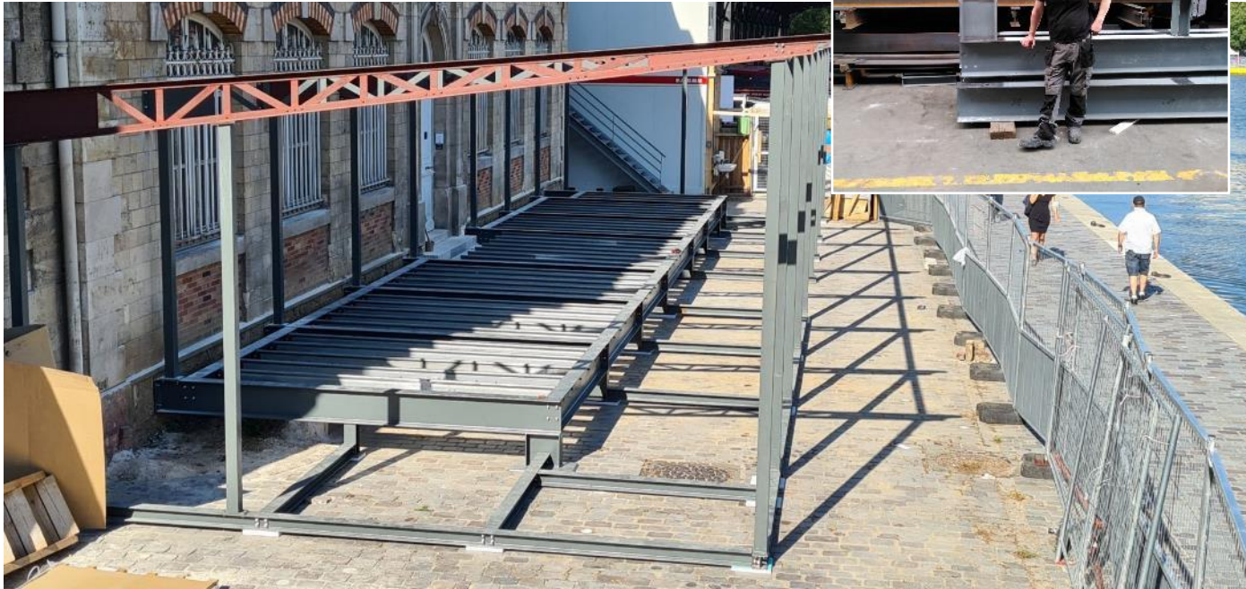
Mise en œuvre de la charpente de la terrasse. Général Métal Edition. Poutres réemploi + cornières déclassées.
