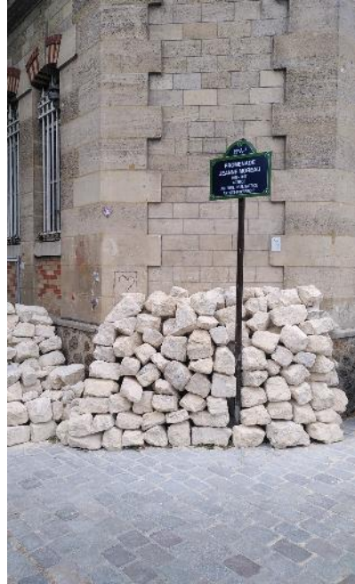
Chantier socle de la terrasse. Pierres issues de la démolition in situ et de la plateforme Ville de Paris de pierre de voirie à Bonneuil.
