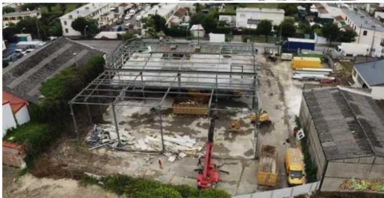
Poutrelles métalliques issues d'un hangar à Bondy
